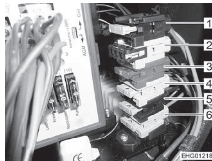
Kuva 111 Sulakkeet sähkö- ja elektroniikkayksikön vieressä (Ford)
