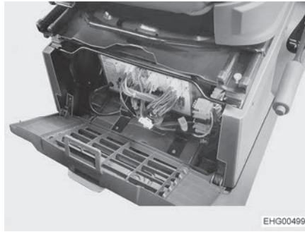
Kuva 76 Sähkö- ja elektroniikkayksikön asennuspaikka (Stellantis)
