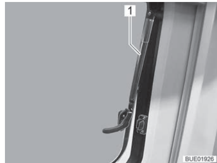
Bild 20 Överkantshängt fönster med automatik-spärrar, öppet
