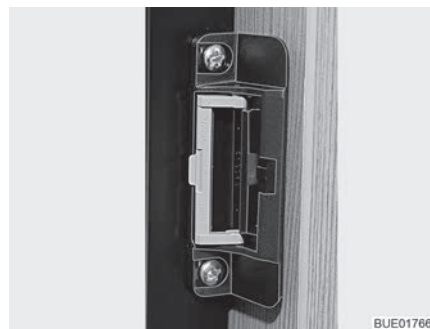
Bilde 104 Låseanordning i luftestilling
