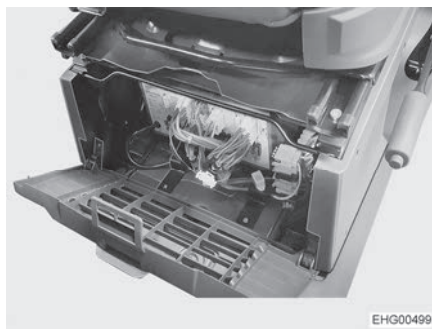
Bilde 76 Monteringssted for strømsentralen (Stellantis)
